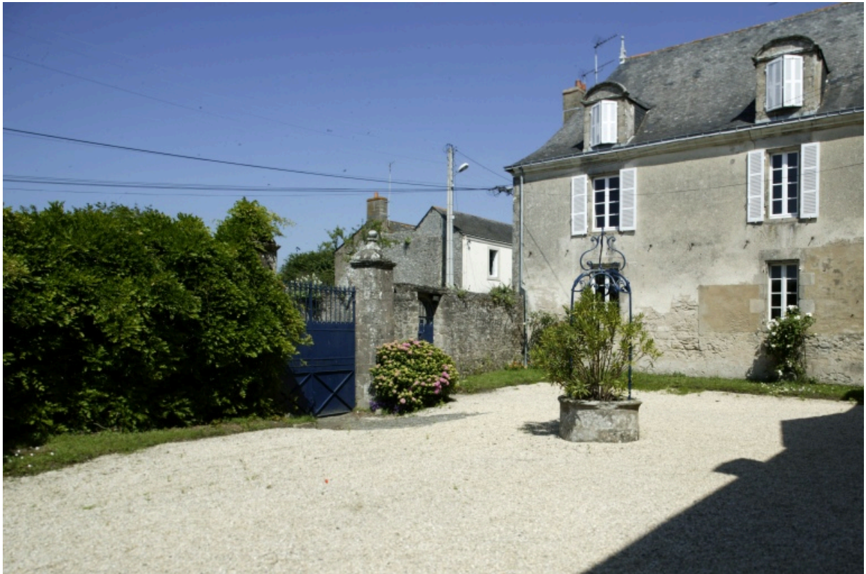
Hôtel de Kerhué et mur de clôture vu depuis la cour vers l'Ouest.
