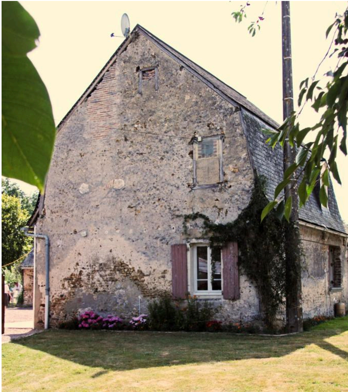
La maison principale avec un comble brisé à croupe.
