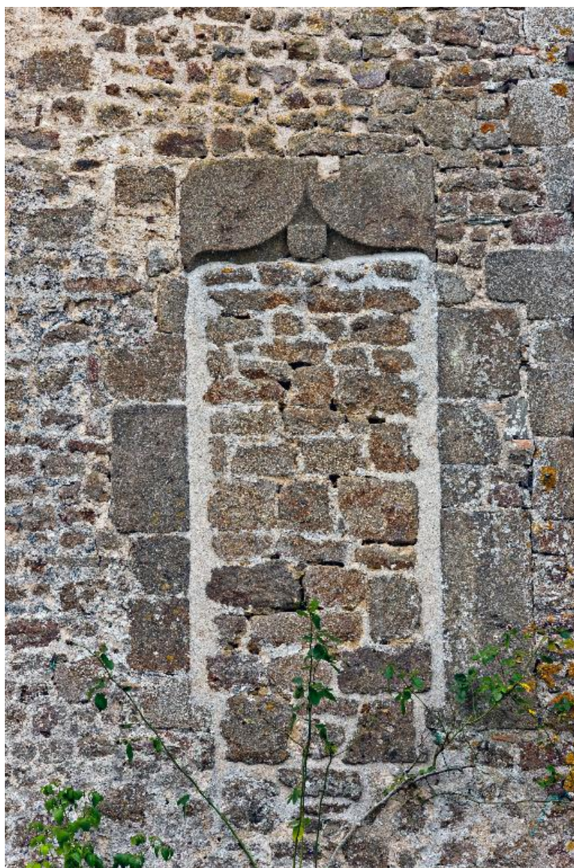
Vue de détail de la la partie nord de l'élévation antérieure du corps principal : la porte haute bouchée située au premier étage.
