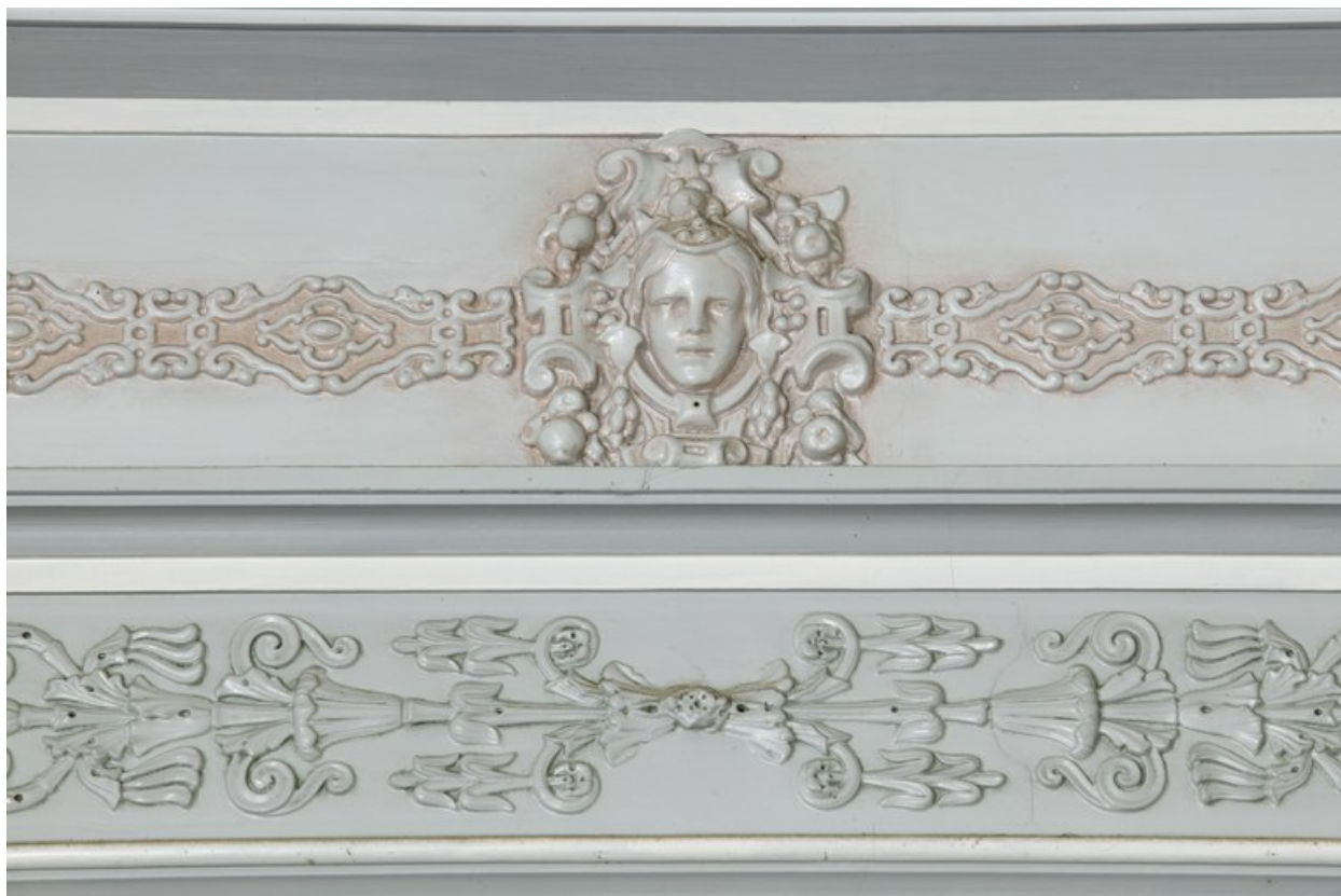
Détail de la cheminée de la photo précédente.
