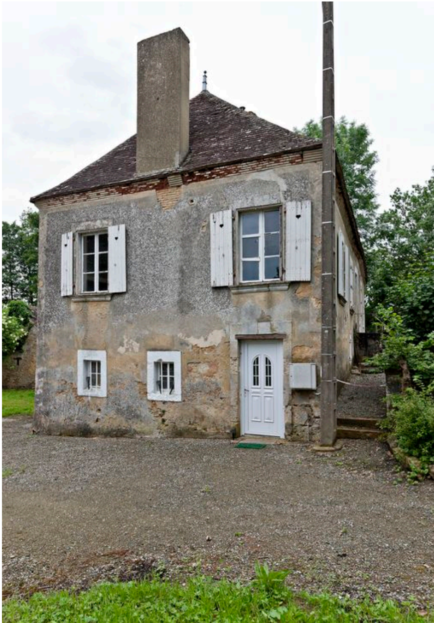
Elevation sud du logis
