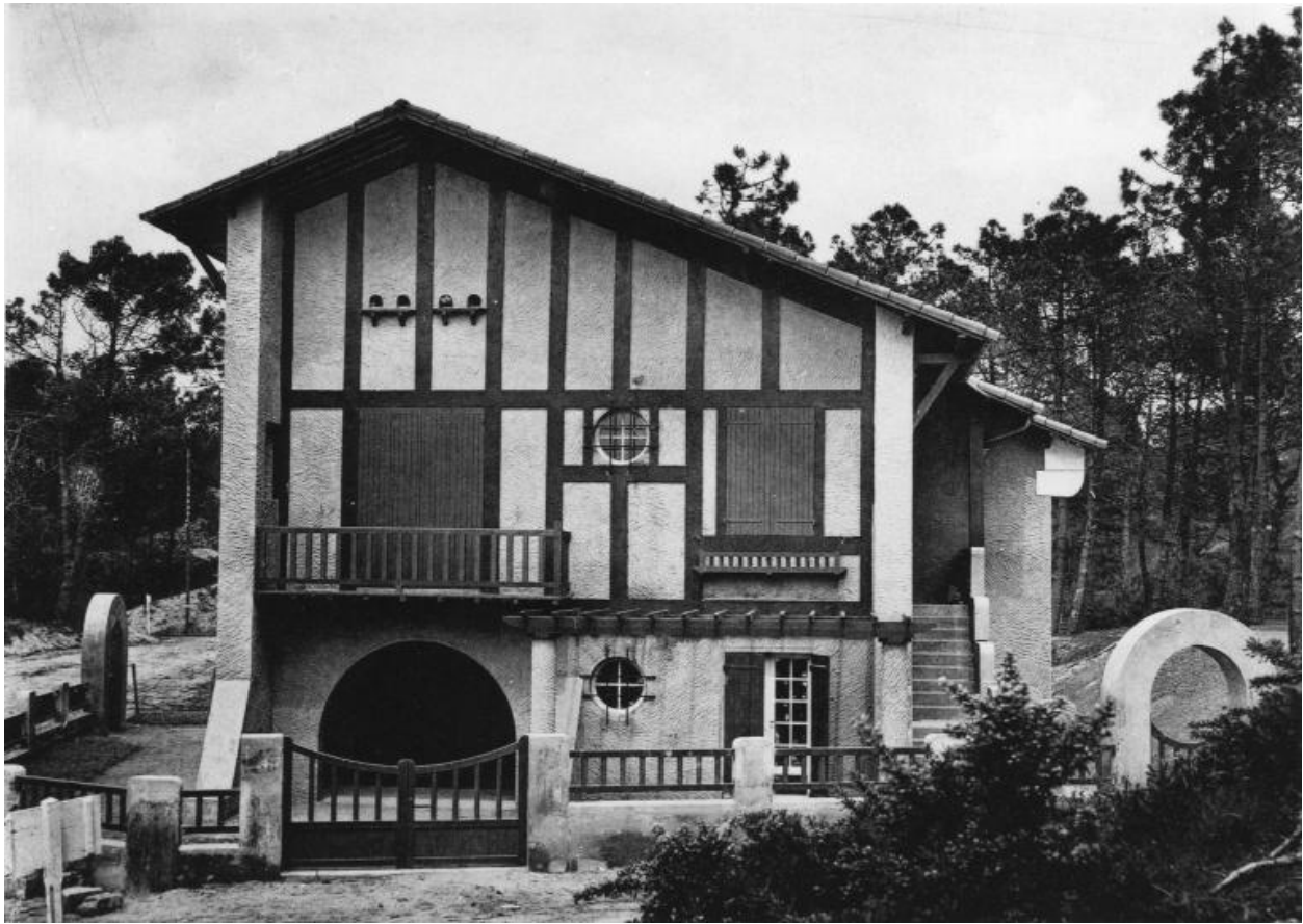
Façade sud de la villa Landaise Abjamico.
