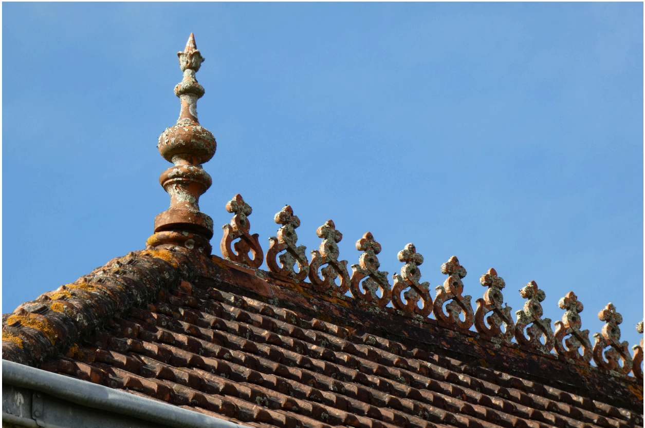
Détail d'un épi et de la crête de faitage.
