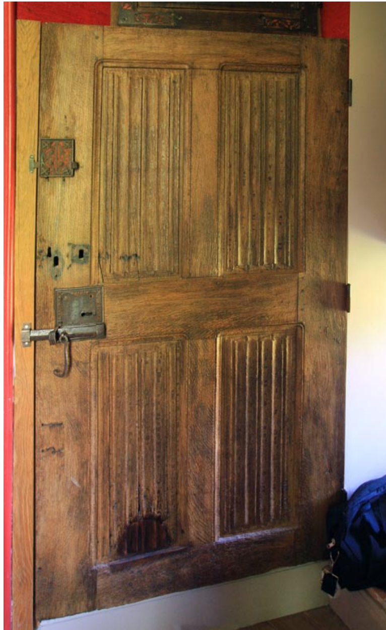
Menuiserie de porte à panneaux de plis de serviette avec sa serrurerie (déplacée).
