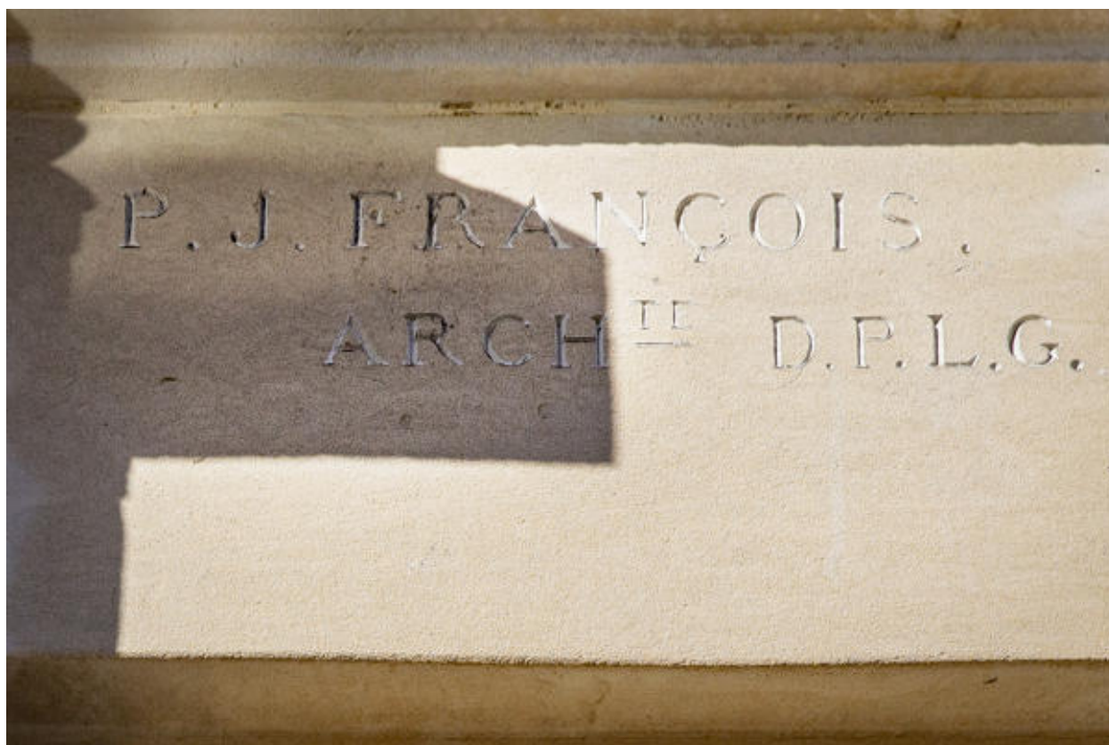
Détail de la plaque d'architecte (François) sur la maison rue Gambetta.
