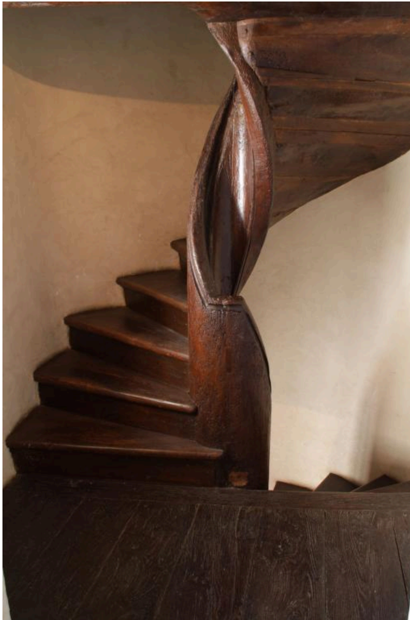
Escalier en vis, en charpente.
