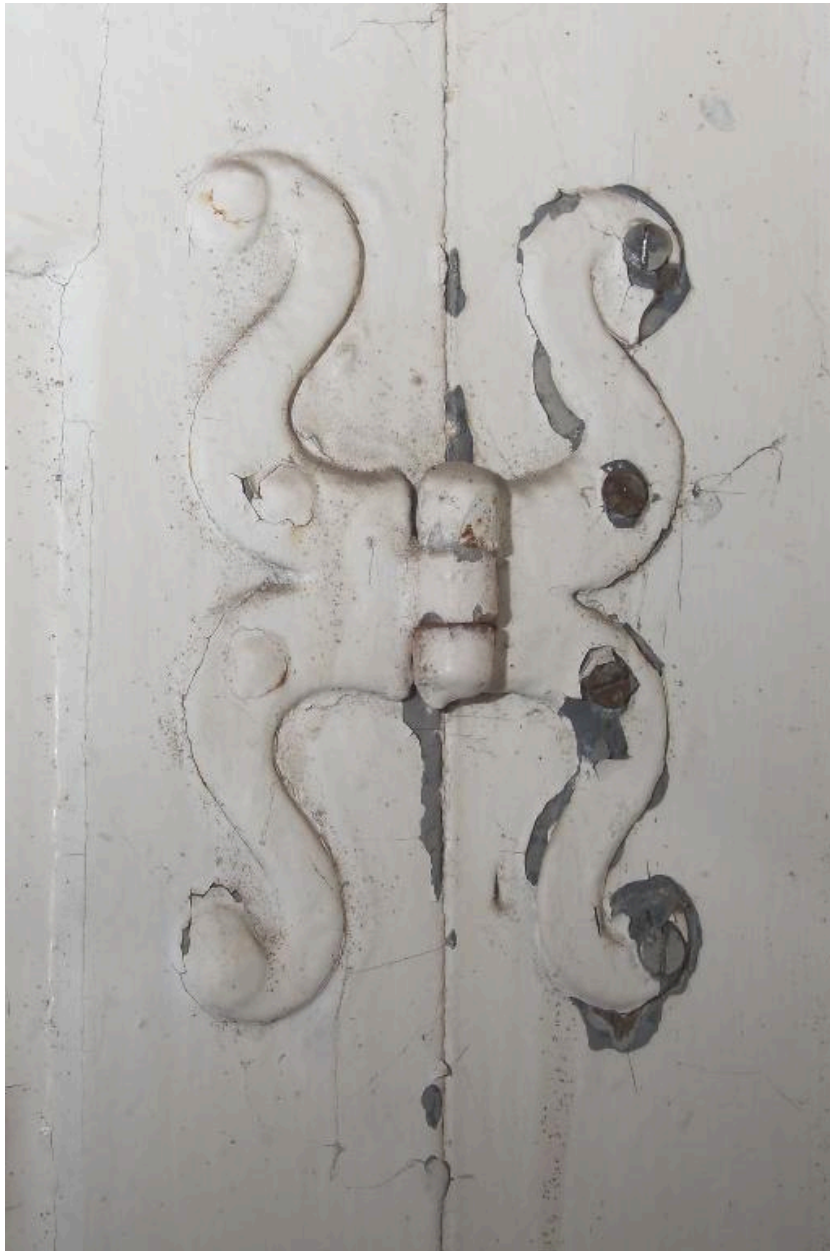
Le corps principal, la porte de communication entre les deux pièces ouest, détail.
