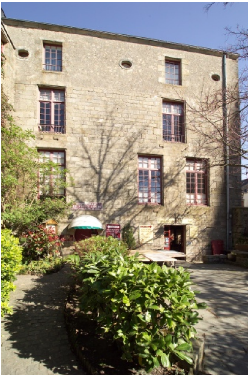
Vue de la façade sud de l'aile bordant la rue Vannetaise.
