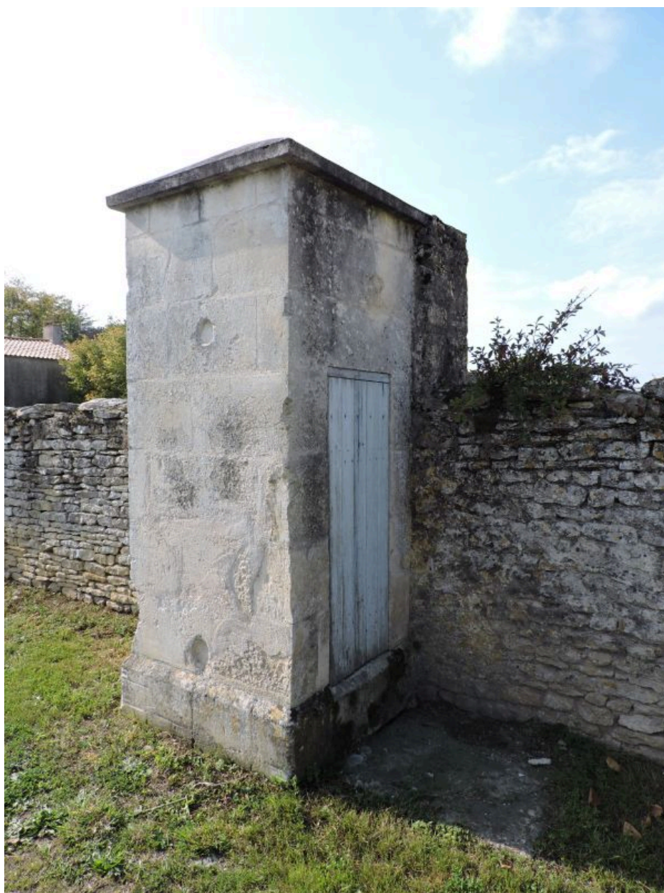
Le puits vu depuis le nord-est.
