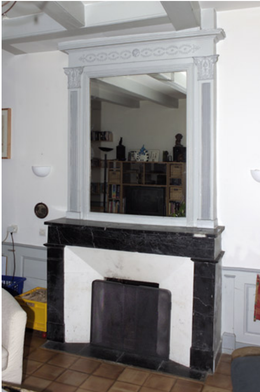
Le corps principal, la pièce située au rez-de-chaussée, détail de la cheminée.
