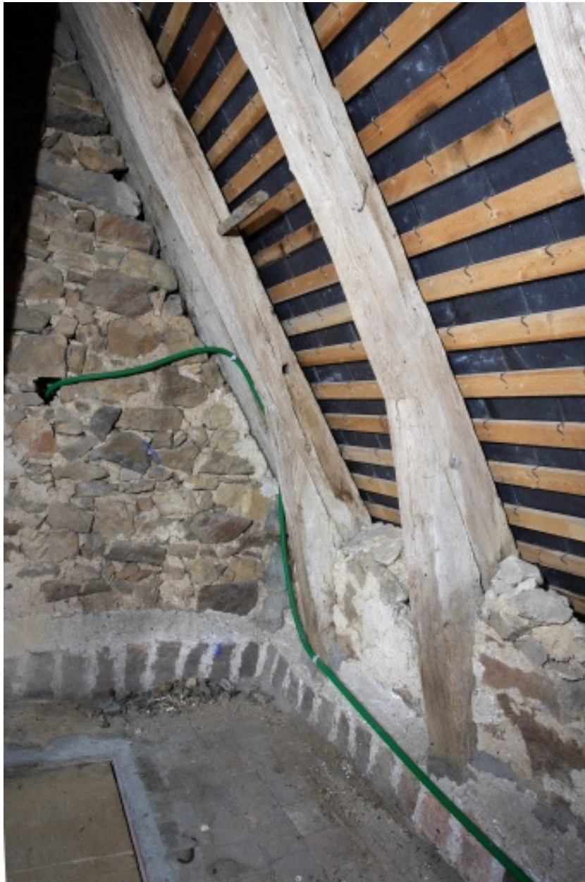
Le logis, corps central, détail de la charpente : base des chevrons au nord-ouest.
