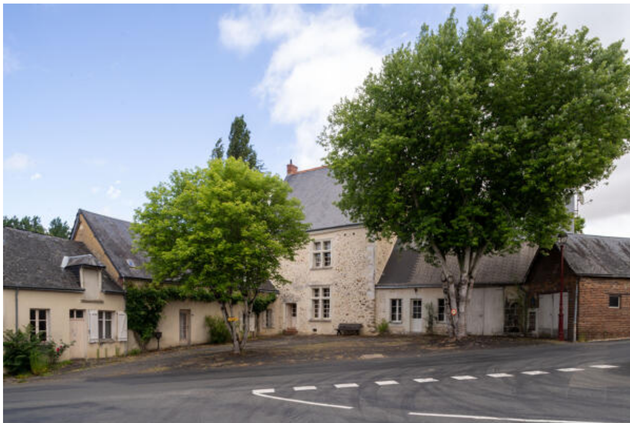
Vue d'ensemble depuis la place de l'Église.
