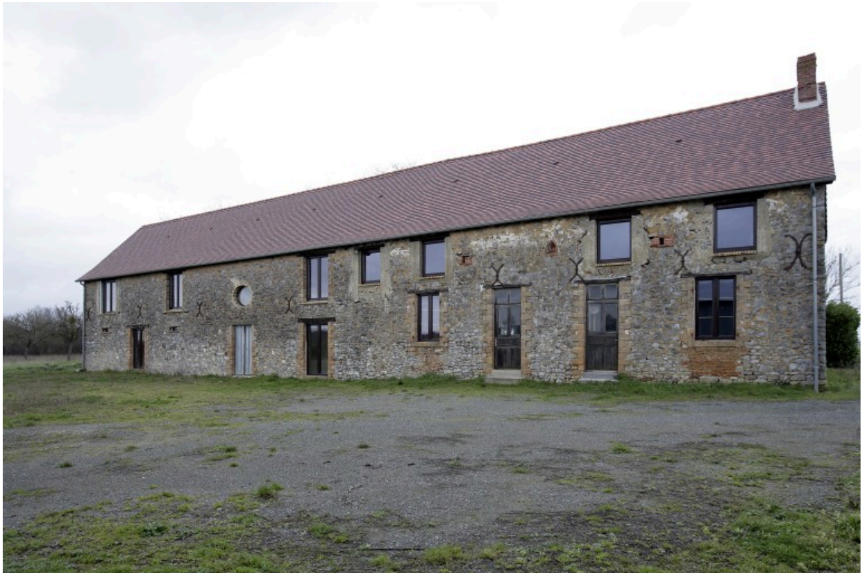
Vue d'ensemble depuis la cour au sud.
