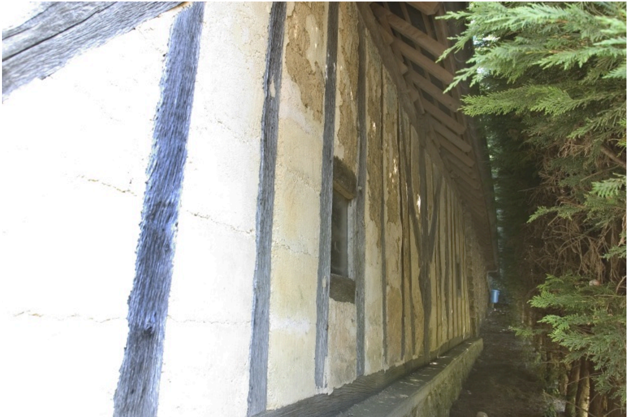
L'étable-grange, élévation postérieure : la partie centrale.
