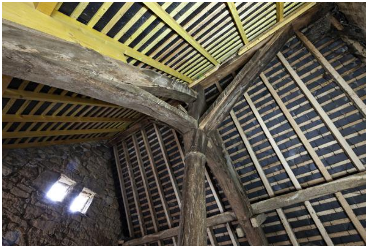
Charpente. Partie haute.
