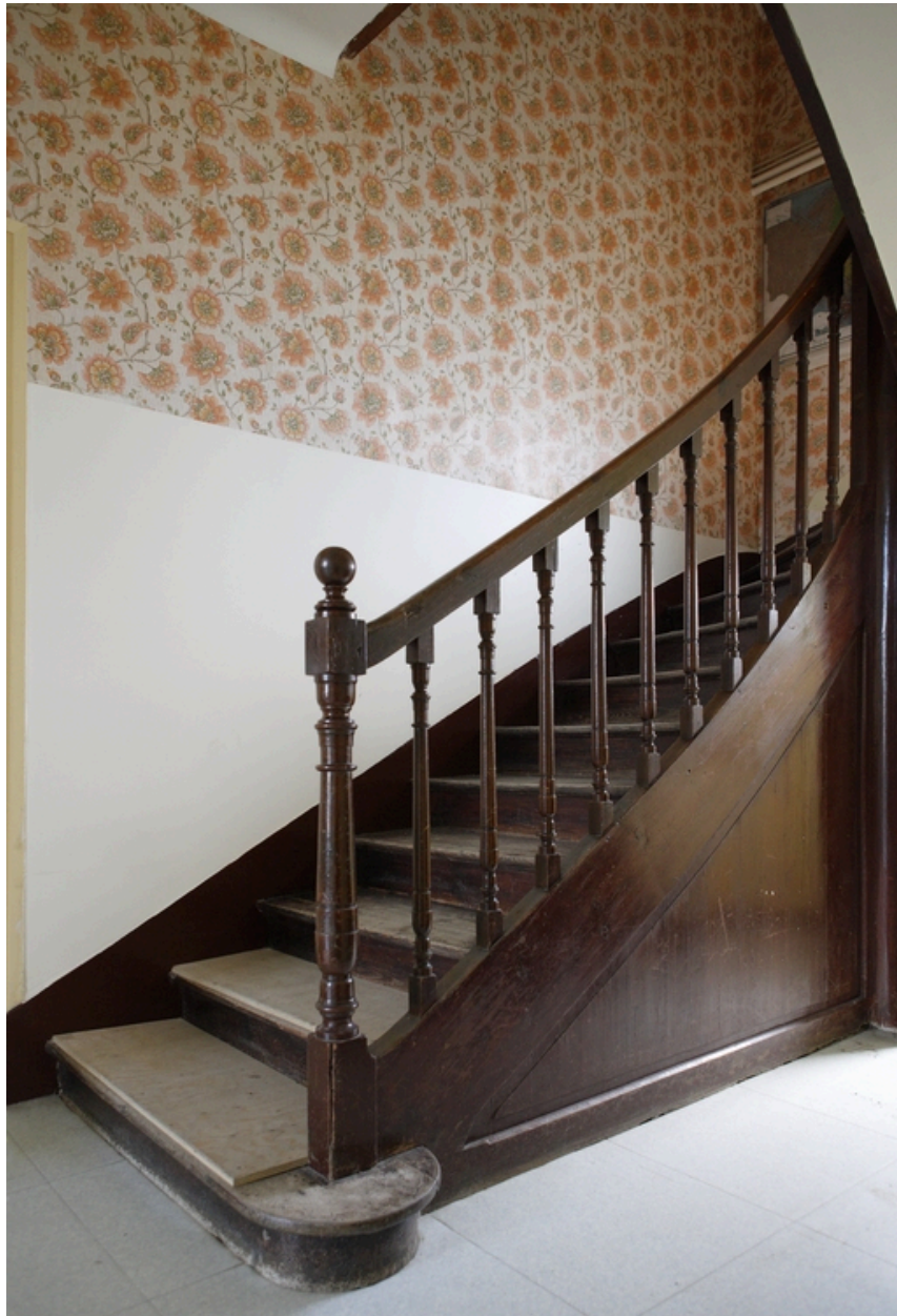
Vue de l'escalier du logement de l'instituteur.
