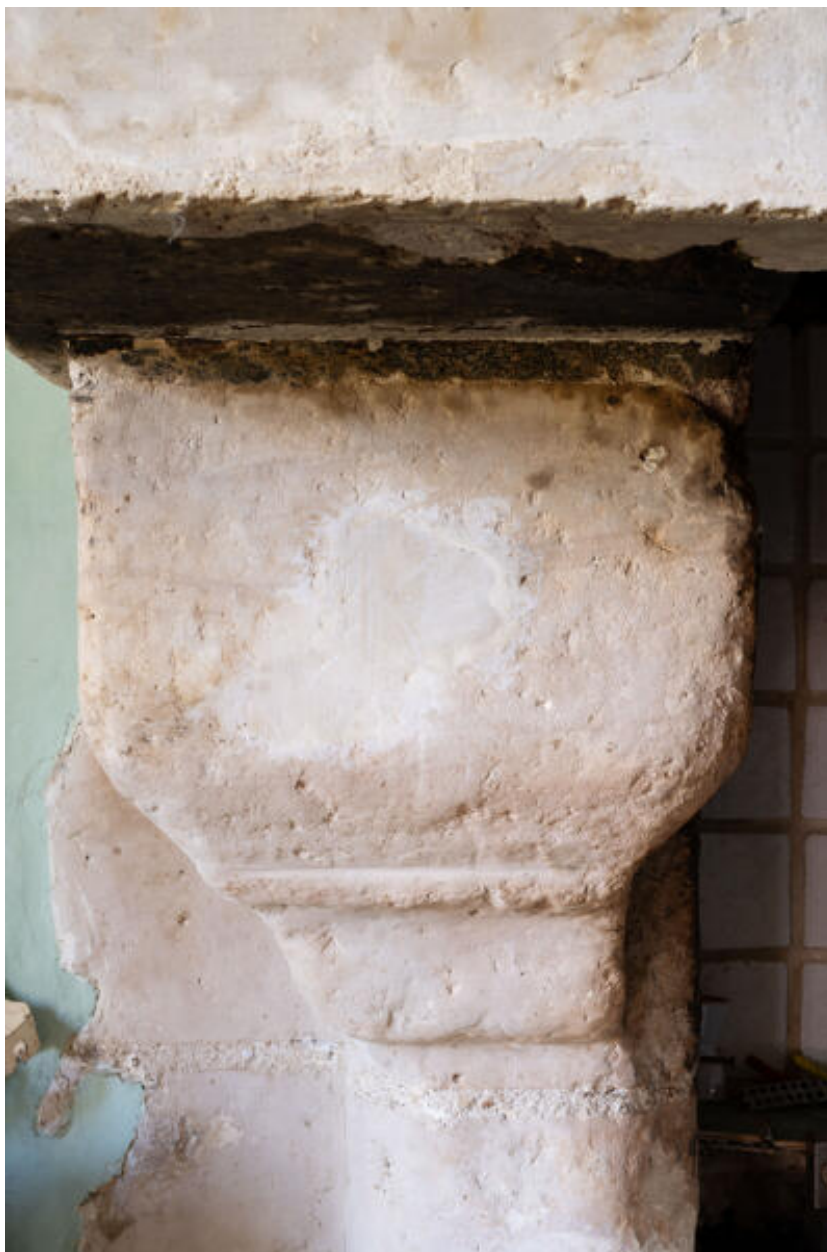
Logis : cheminée du rez-de-chaussée, pignon ouest ; détail de console.
