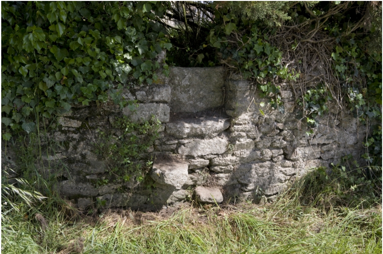
Vue de l'échelier sur le mur de clôture sud de la métairie.
