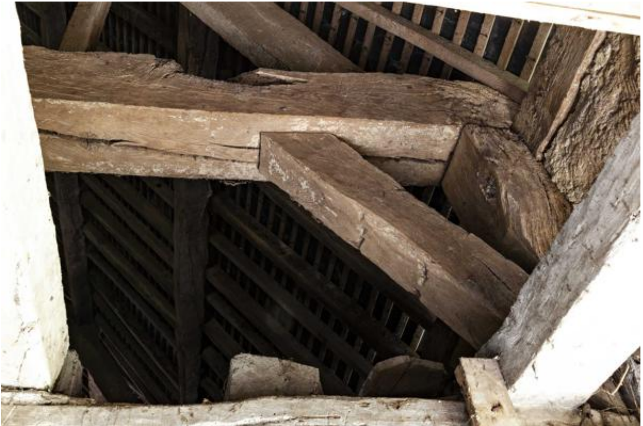
Poteau, entrain et lien de la grange.
