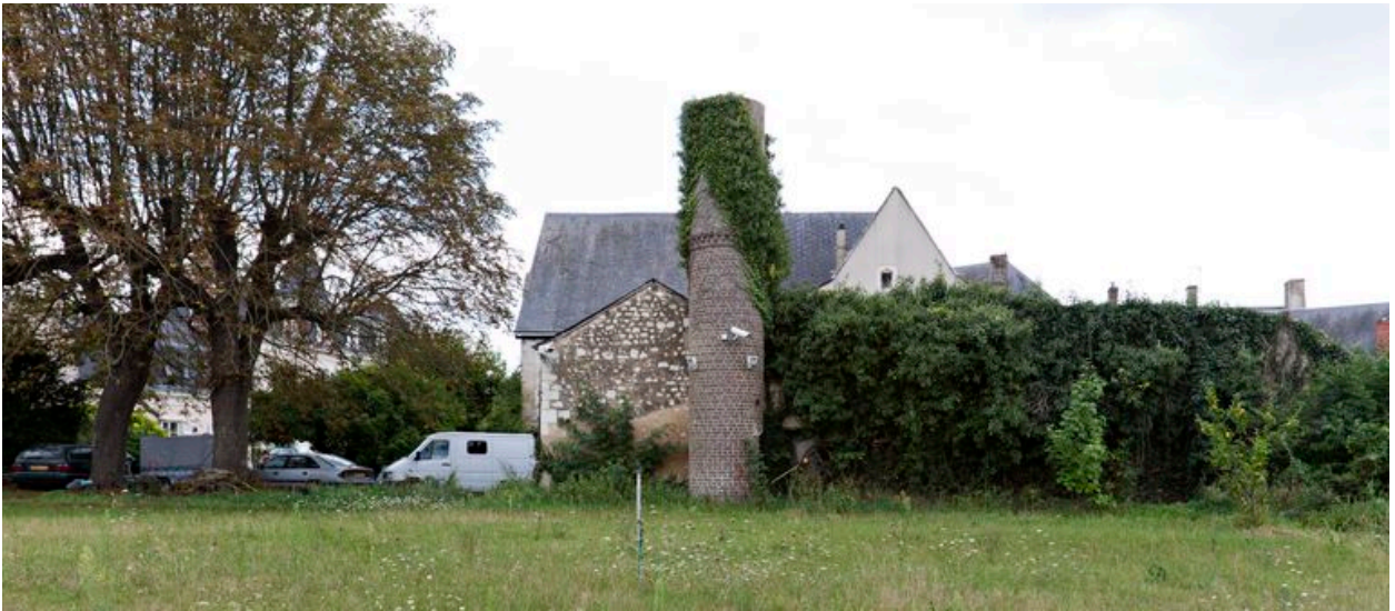
Vue d'ensemble prise du nord.
