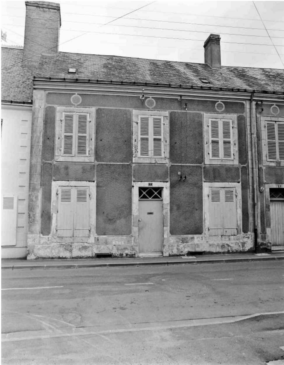
Une maison du XIXe siècle, Grande rue, 1978.
