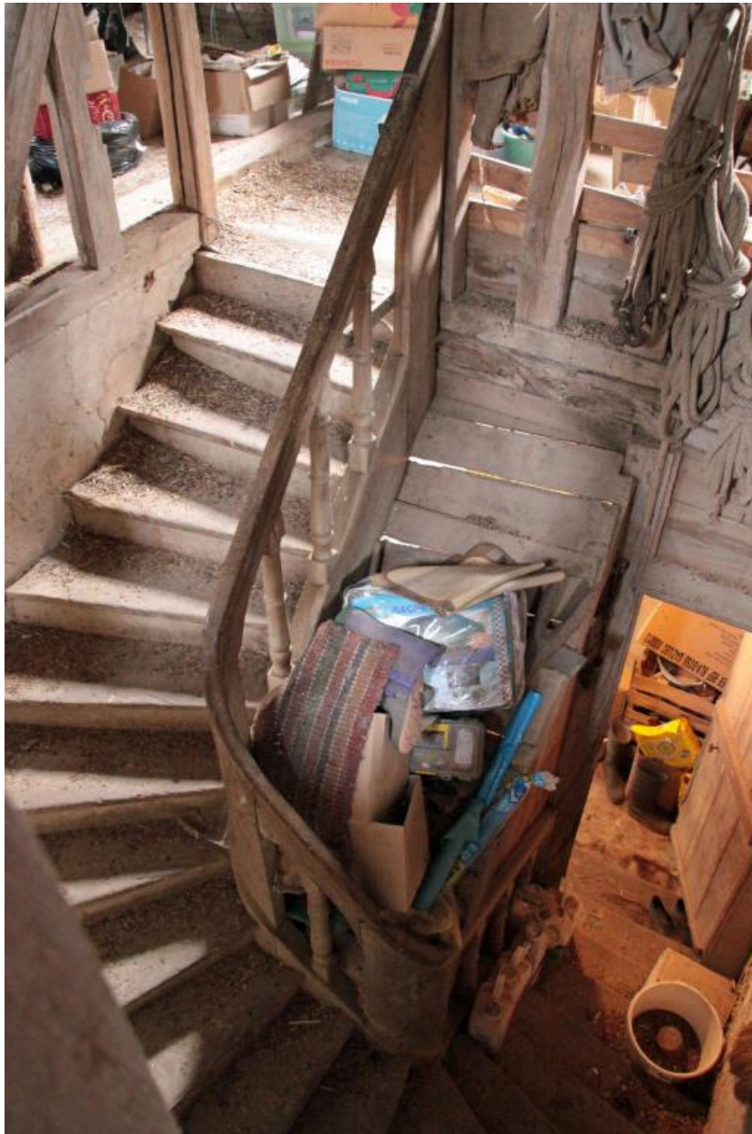
Maison, rez-de-chaussée : escalier central.
