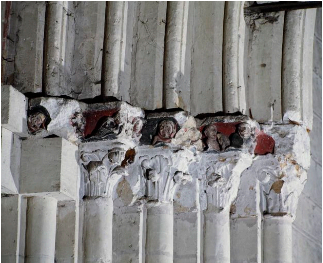
Support nord de la seconde travée de la nef. Chapiteaux et tailloirs des colonnes engagées, ornés de figures en bas-relief : les damnés (vue prise en 1991).
