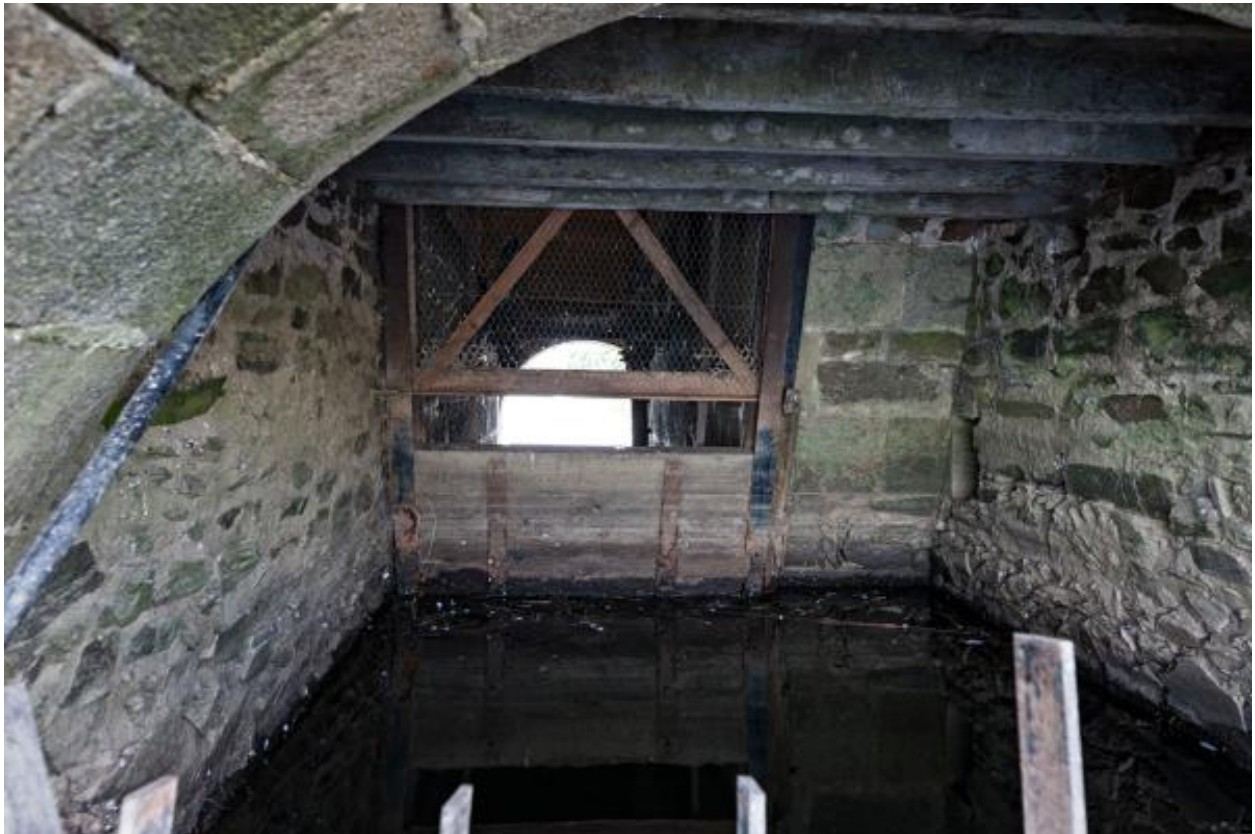
Le passage d'eau et la vanne d'amont vus depuis le nord.
