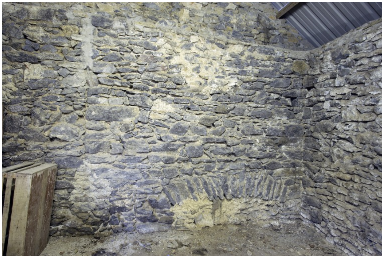
Bâtiment sud, pièce est, mur est : arc.
