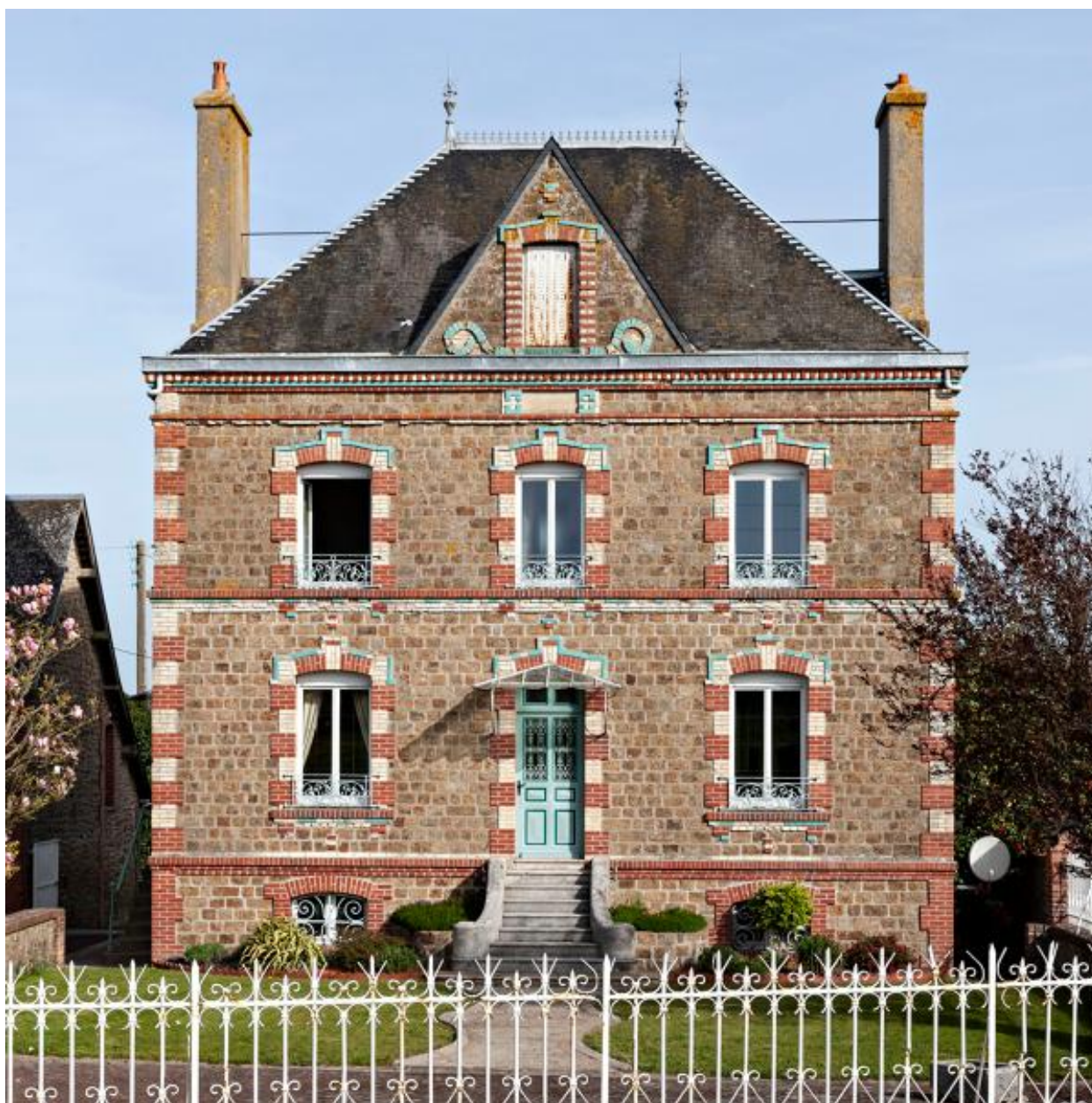
Ferme du Fresne, maison.
