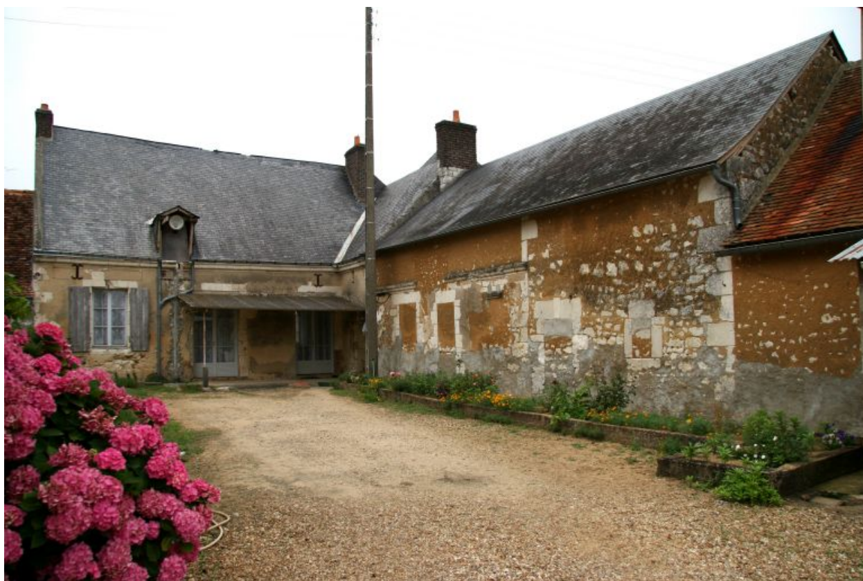
La Haute-Morinière : façade sur cour.
