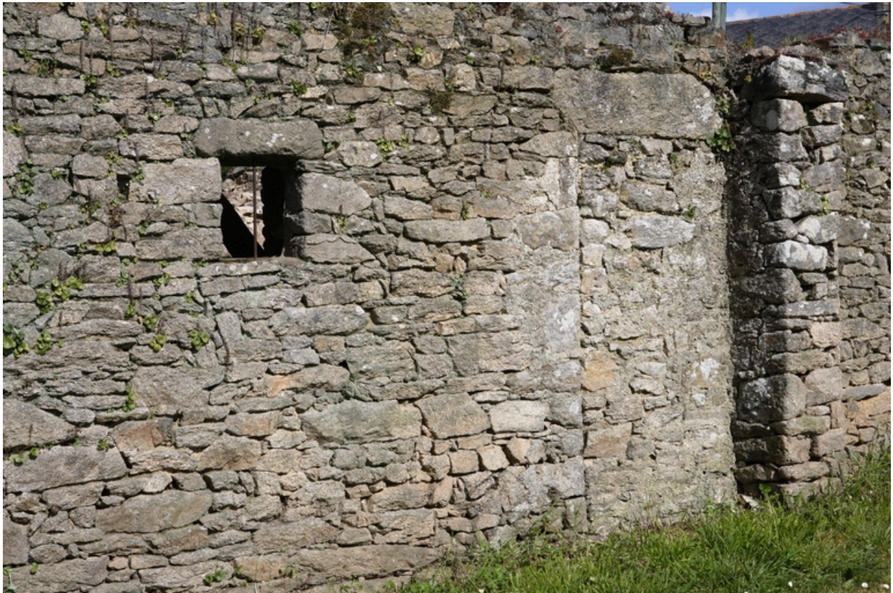
Détail des contreforts de la grange.
