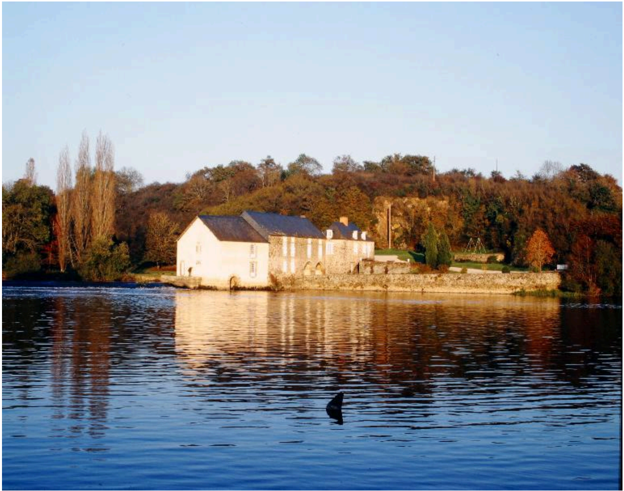
Vue d'ensemble depuis la rive droite en aval.
