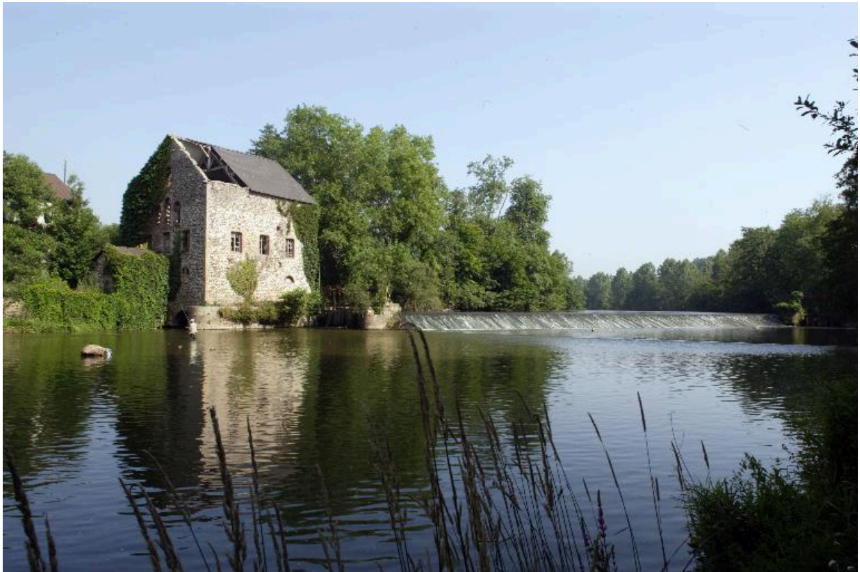
Le moulin à farine et le barrage vus depuis la rive gauche en aval.
