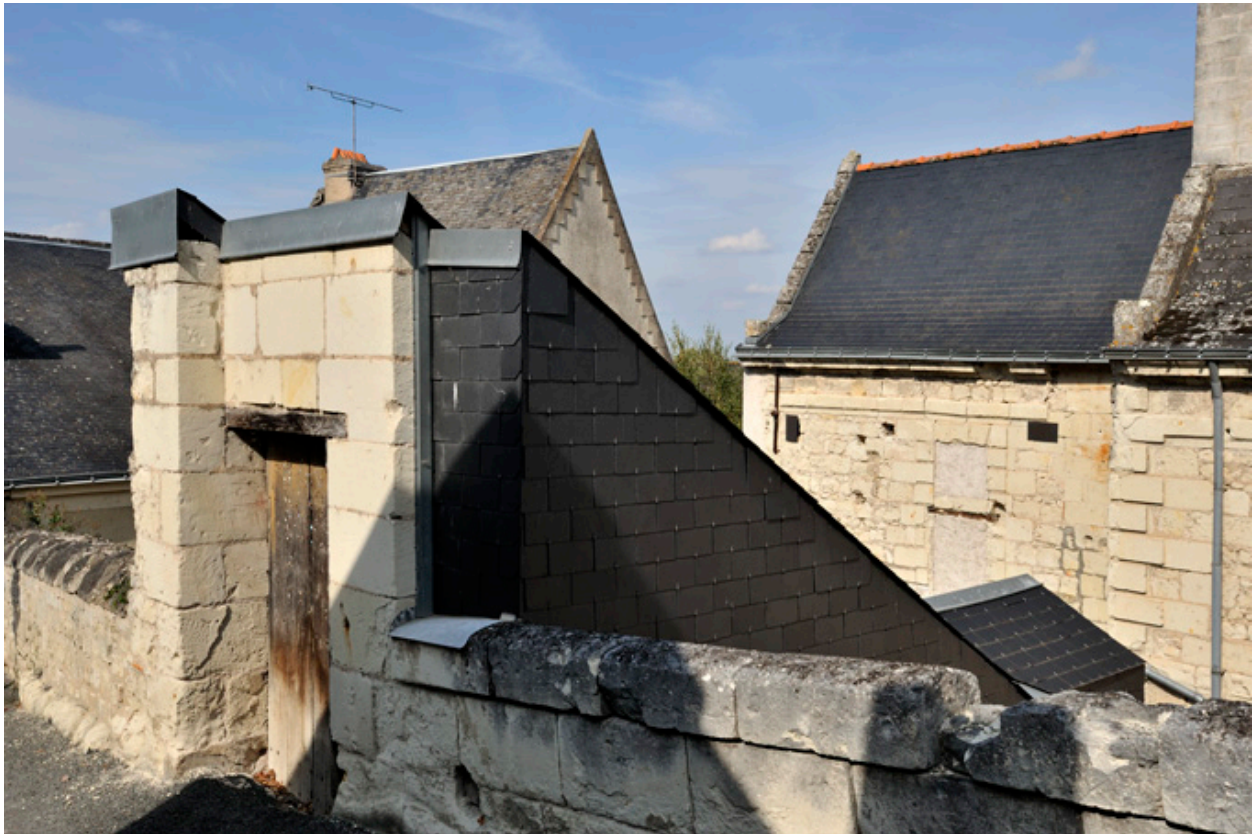
Porte de l'escalier extérieur couvert, rue Françoise de Maridor.
