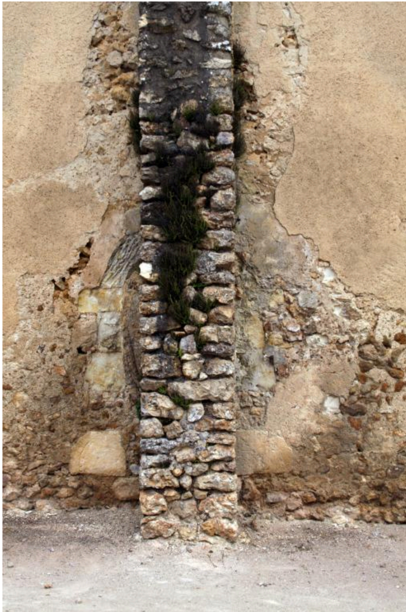
Nef, mur sud, détail : porte murée sous le contrefort.
