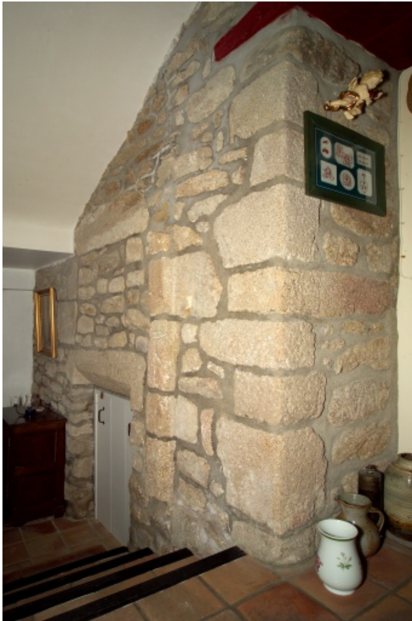
Vue de la cage d'escalier.
