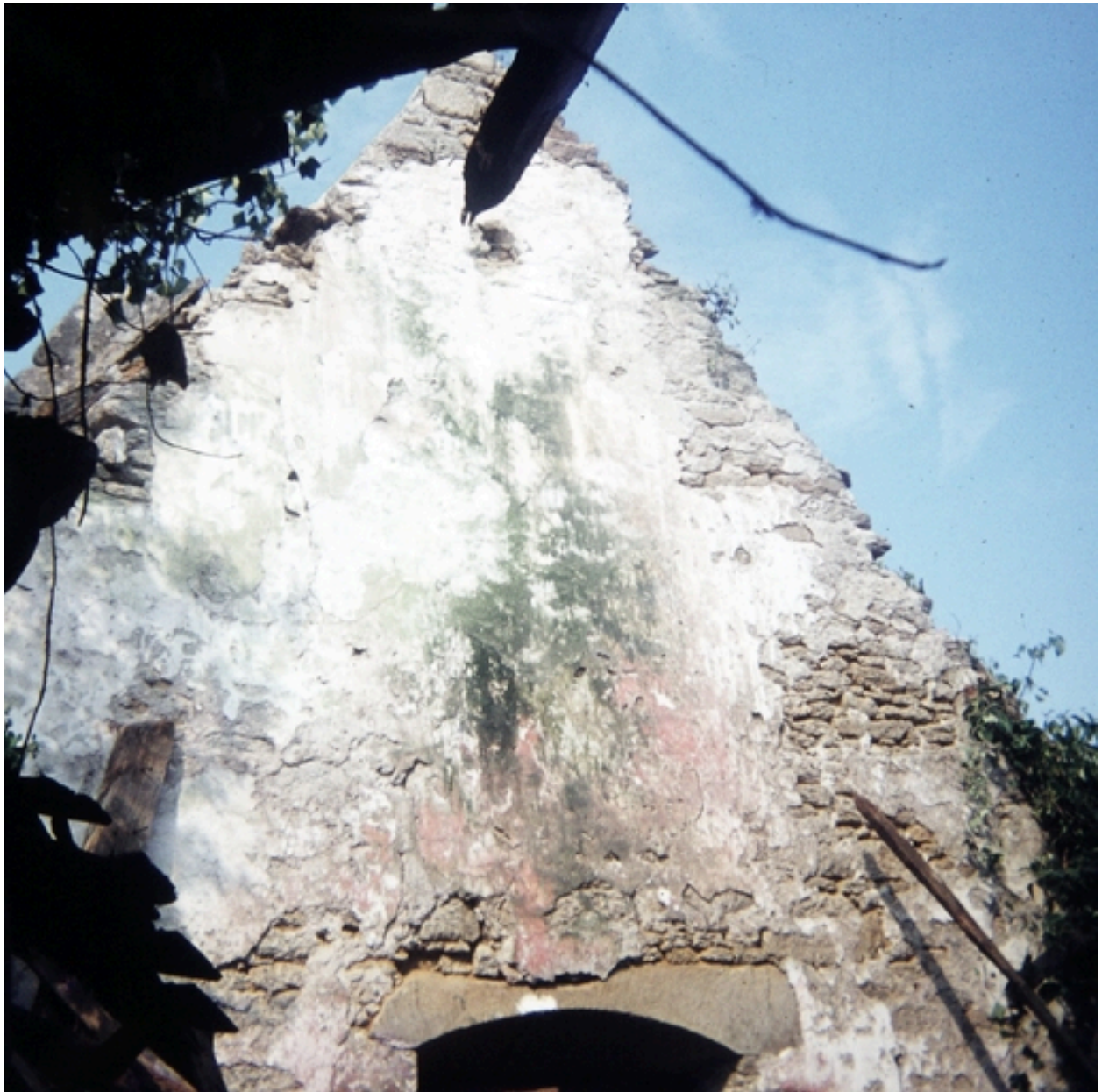
Vue du pignon ouest (intérieur). Photo. Y. Maurice, 1976.
