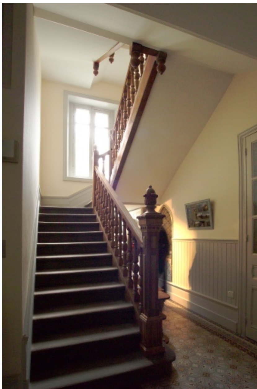
Dégagement au rez-de-chaussée, vue de l'escalier.
