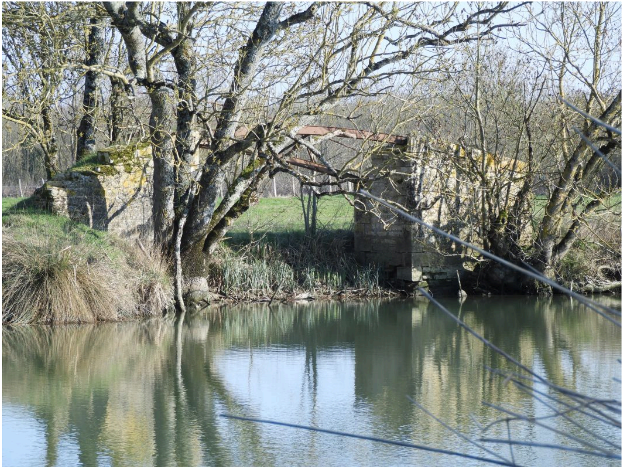
La passerelle vue depuis l'ouest.
