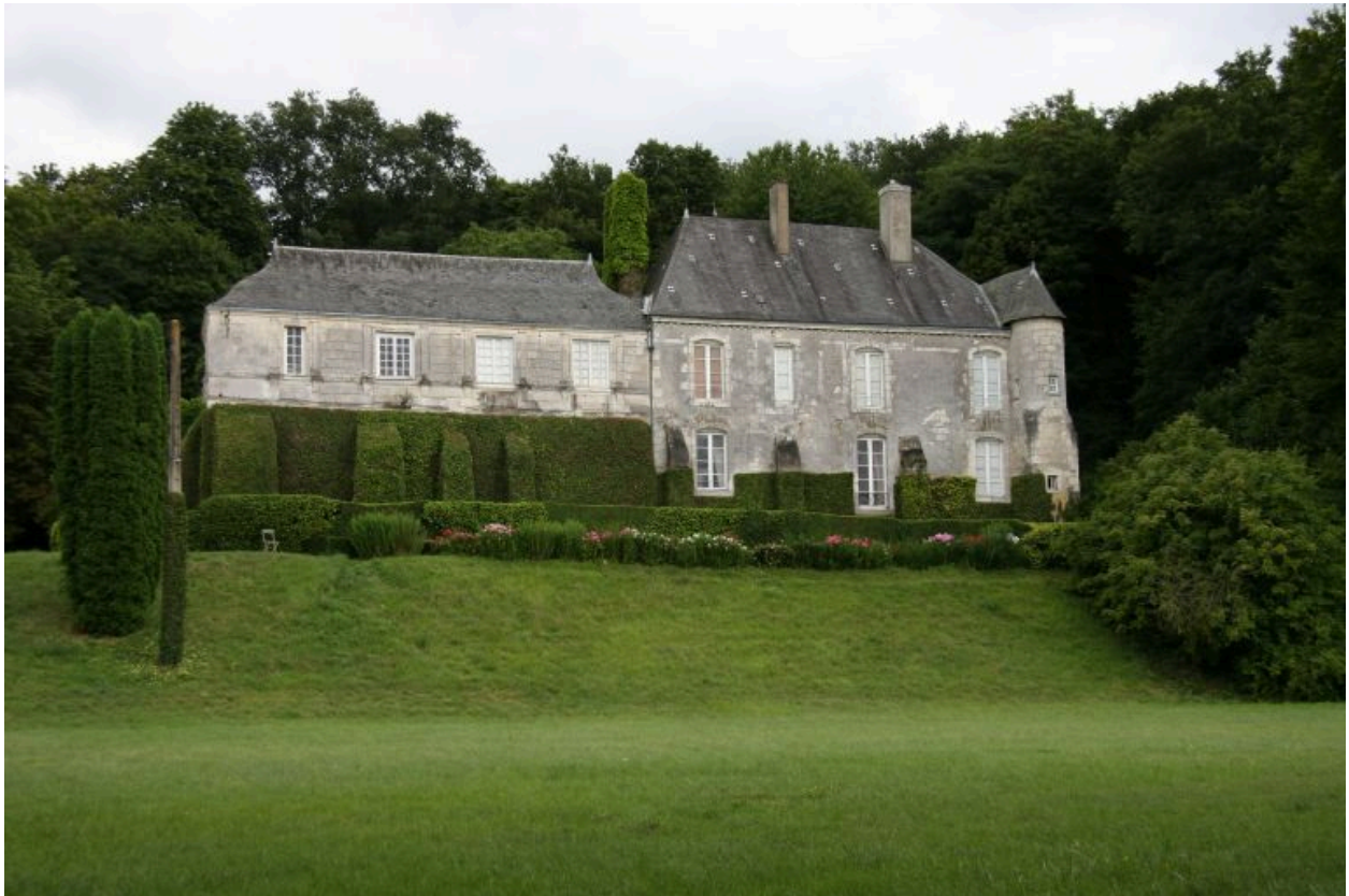
Vue d'ensemble prise du nord : le logis et la galerie.
