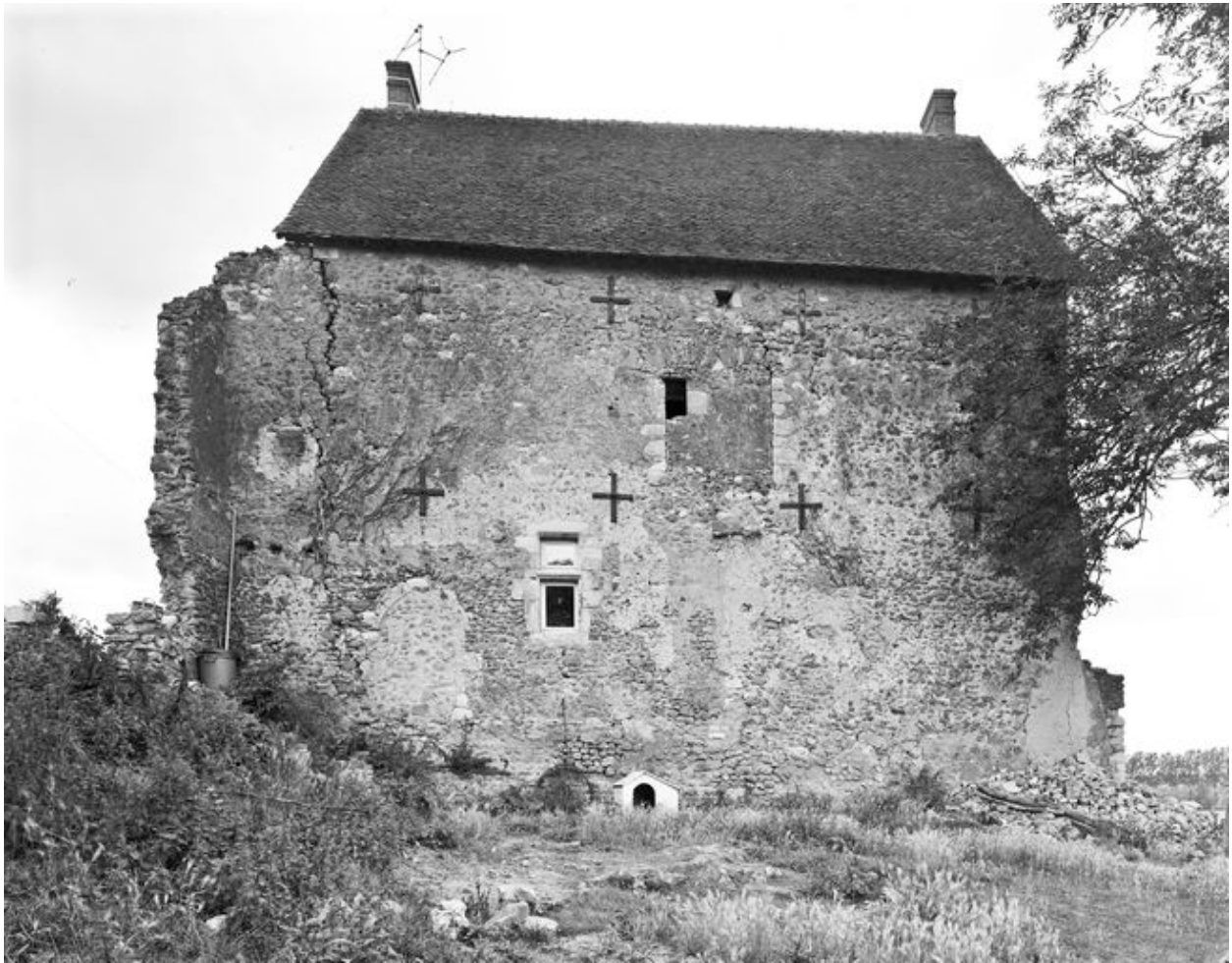
La façade nord-est, 1979.
