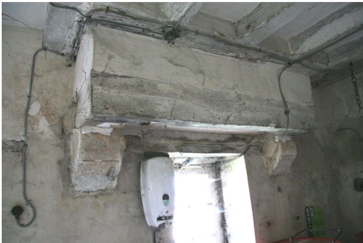
La vieille ferme, pignon sur le chemin : vestige de la cheminée de la salle d'habitation.
