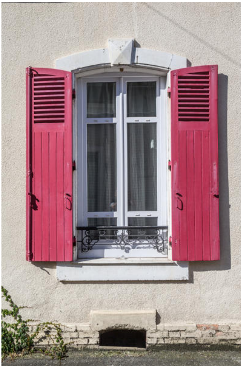
Vue d'une fenêtre en rez-de-chaussée d'une mancelle.
