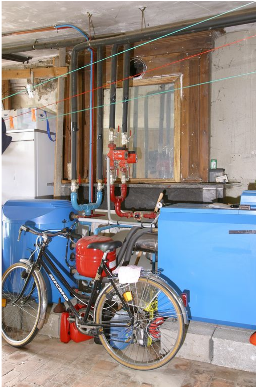
Rez-de-chaussée, salle nord : la cheminée.
