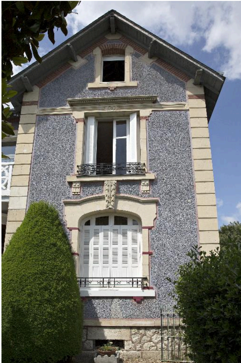
Façade côté rue : travée de droite.
