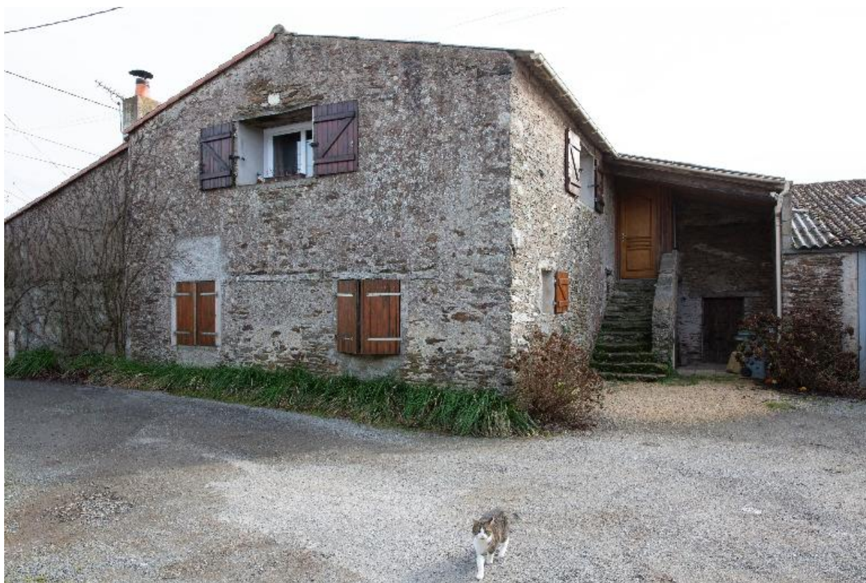
Habitation à deux niveaux, BM01-586, cadastre 2018.
