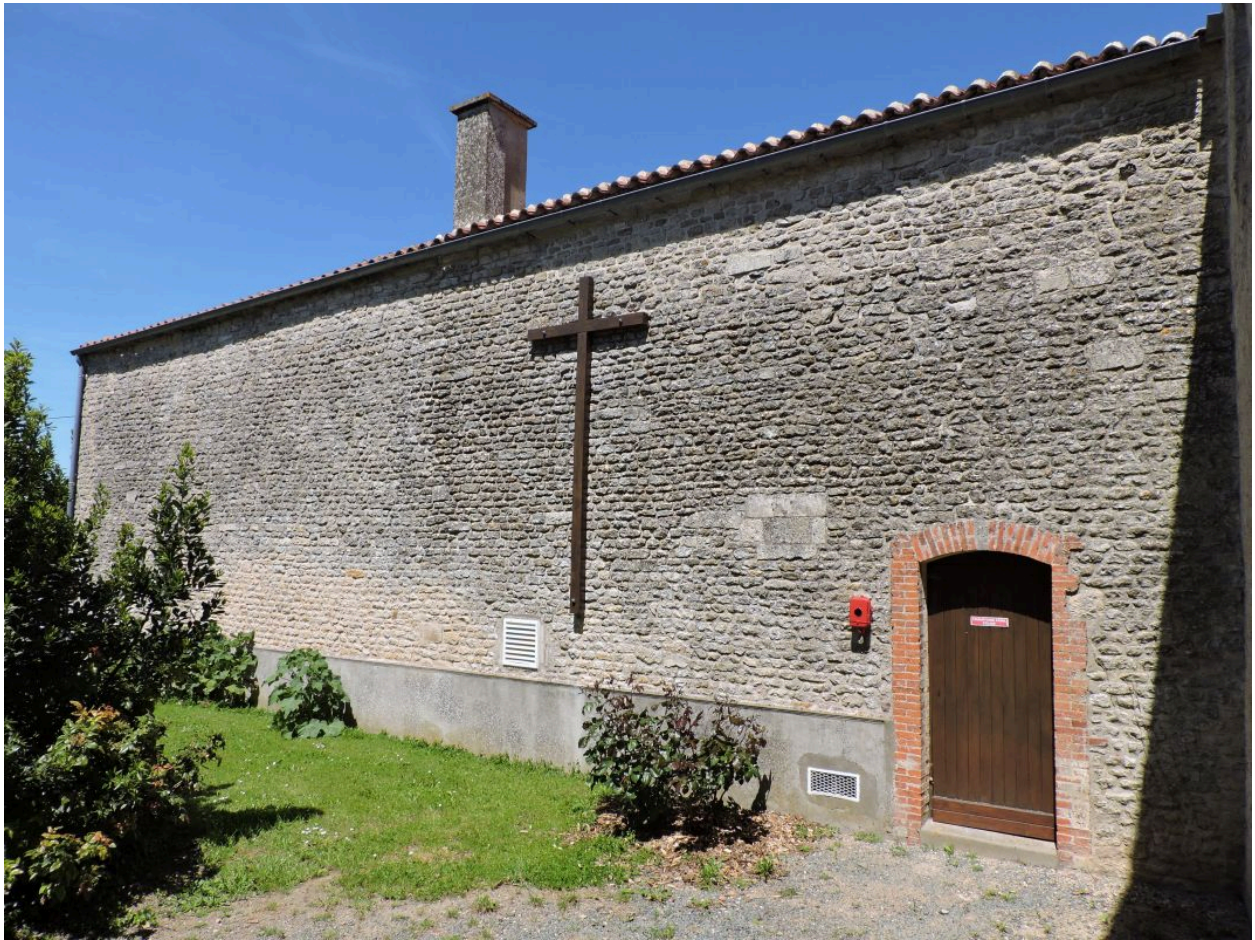
Le mur de l'ancienne église, avec la croix en bois rappelant la fonction du lieu et la porte de la chaufferie, vu depuis le sud-est.
