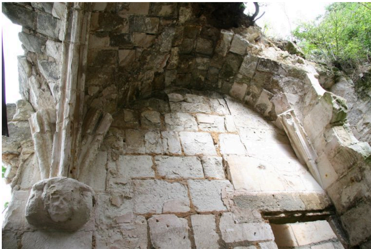
Ancien château, 1er étage : travée voûtée d'ogives avant l'escalier.
