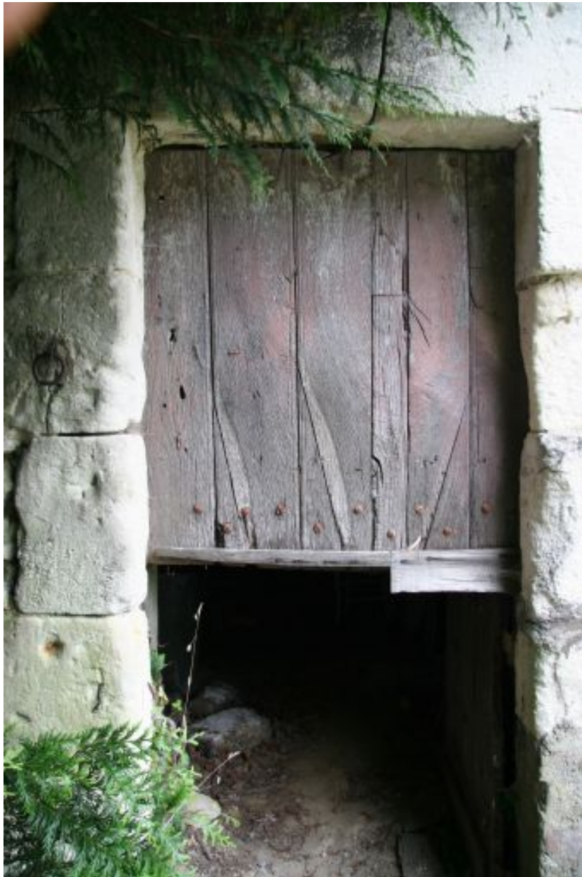
Maison 1, salle gauche : porte d'entrée à deux battants.
